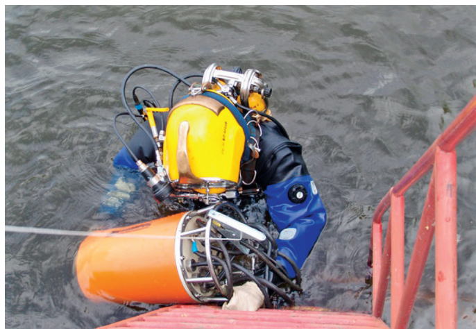
Рис. 7. Спуск сварщика-водолаза с погружным блоком установки УПС-1 в реку Лена для проведения ремонтных работ
