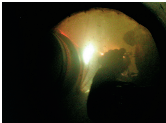
Рис. 8. Подводные ремонтные работы с использованием сварки в мини-кессоне
