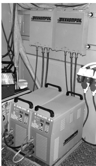
Рис. 3. Расположение сварочных источников ДС 400.33-УКП с аппаратурой управления УАСТ-УКП в кунге колесного тягача «Урал»
