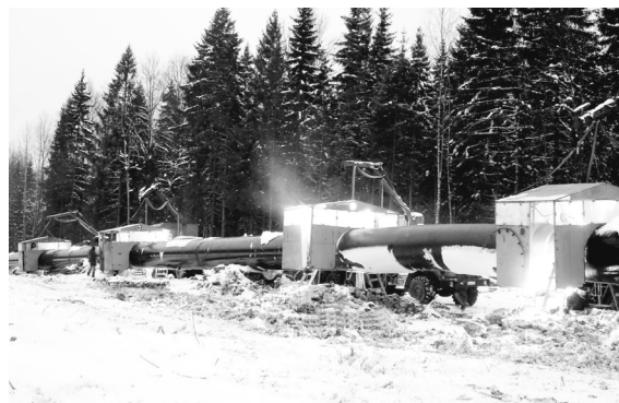
Рис. 6. Сварка поточно-расчлененным методом с применением четырех сварочных постов
