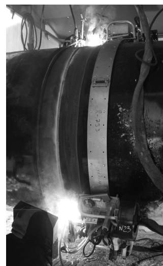
Рис. 5. Заполнение разделки и выполнение облицовочного прохода на магистральном газопроводе «Починки-Грязовец»
