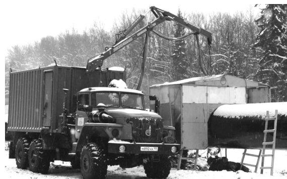
Рис. 4. Выполнение сварочных работ в зимних условиях
