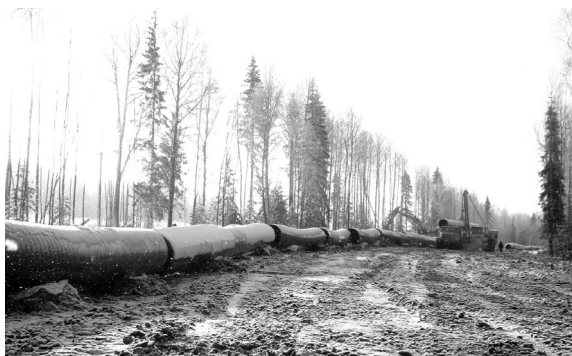
Рис. 2. Раскладка труб на трассе
