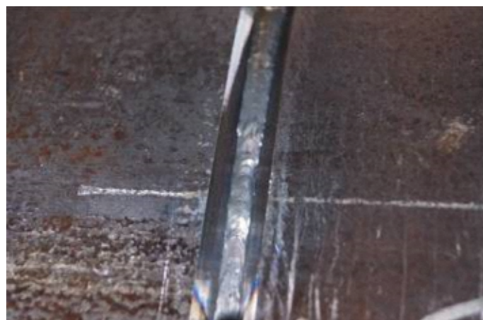
Вид сварочного шва
