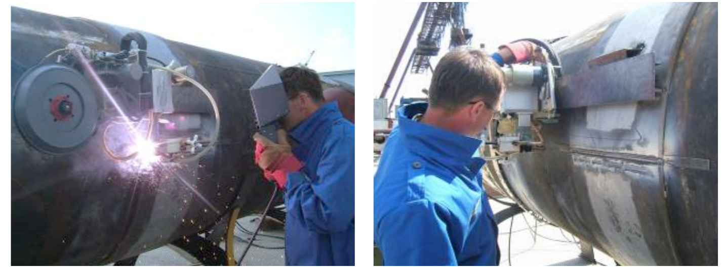
УАСТ-1 при сварке муфты
