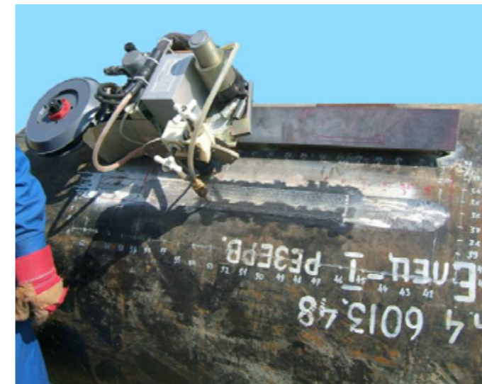
УАСТ-1. Заварка дефекта
