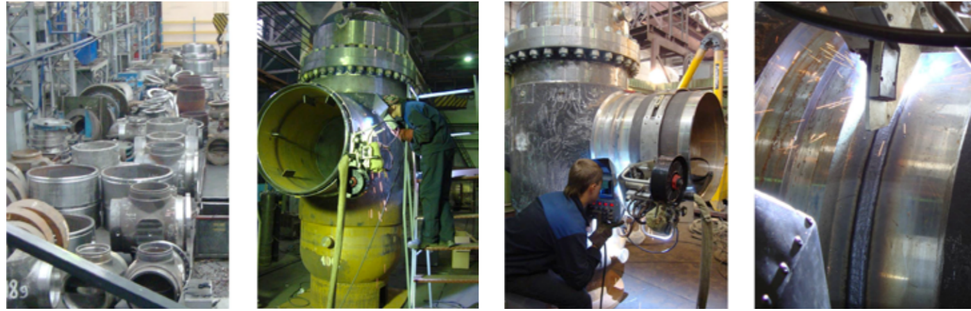
Сварка шиберных задвижек d500-1200 мм с катушками
