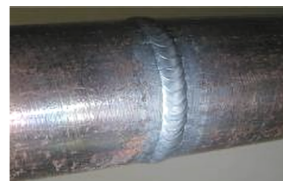
Сварочный шов на трубе 28x3
