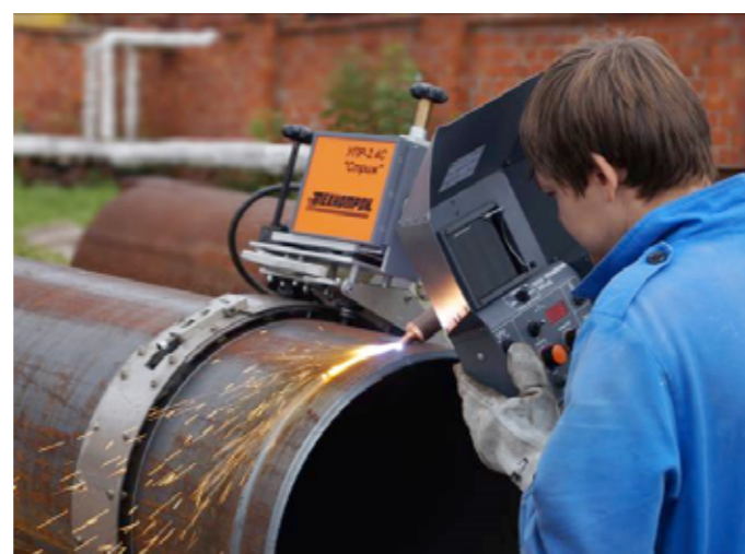
Процесс выборки дефектного шва находится под контролем оператора
