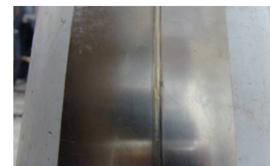
Наружная поверхность шва
