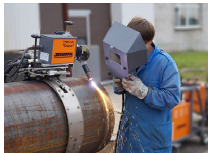
Выборка дефектного шва на трубе Ø530мм
