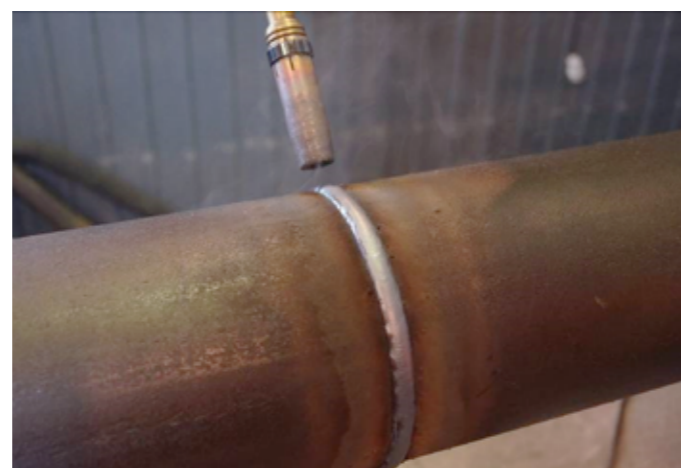
Вид сварочного шва трубы 325x16
