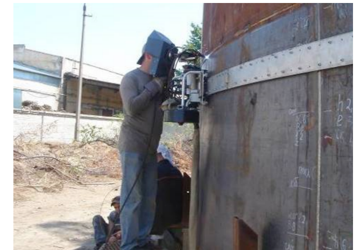
УАСТ-1 на сварке цилиндрических резервуаров (вертикальные и горизонтальные швы)
