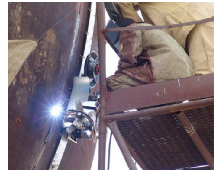
УАСТ-1 на сварке шаровых резервуаров
