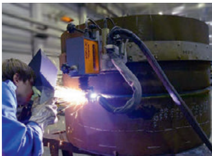
Выборка дефектного шва на трубе Ø1420мм
