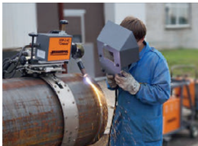
Выборка дефектного шва на трубе Ø530мм
