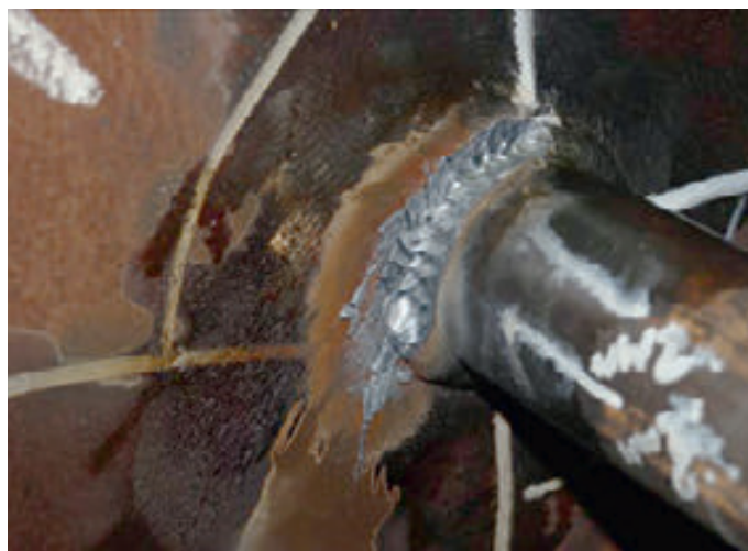
Выборка дефекта в ручном режиме
