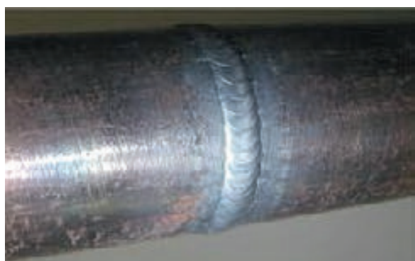
Сварочный шов на трубе 28x3
