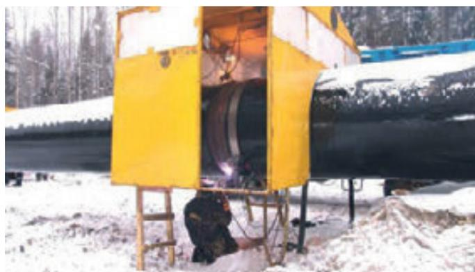
УАСТ-1 на трубе. Сварка стыка 2-мя головками самозащитной проволокой Innershield NR208S
