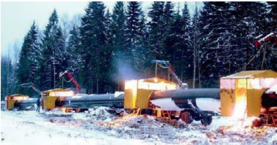
УАСТ-1 Сварка трубопровода (поточно-расчленённым методом, 8-ю комплексами УАСТ-1)
