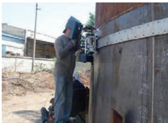
УАСТ-1 на сварке цилиндрических резервуаров
