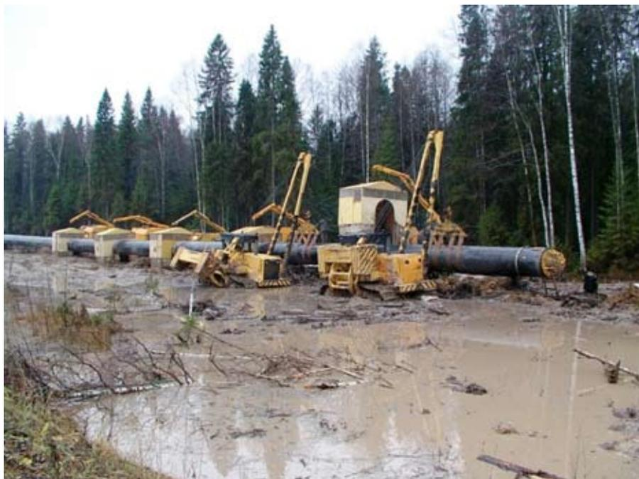
Рис. 6. Сварка трубопровода установками УАСТ-1
