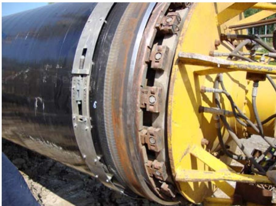
Рис. 5. Установка центратора с медным подкладным кольцом
