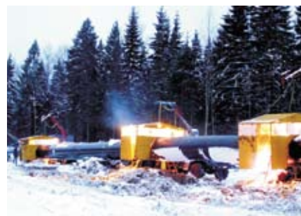
Рис. 3. Сварка трубопровода установками УАСТ-1
